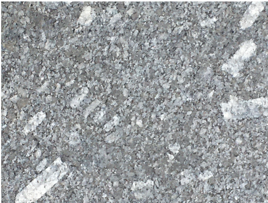
Granite porphyrique avec fluidalité magmatique, utilisé comme bordure de trottoir à Lille, place de la gare LF. ©B.Maitte
